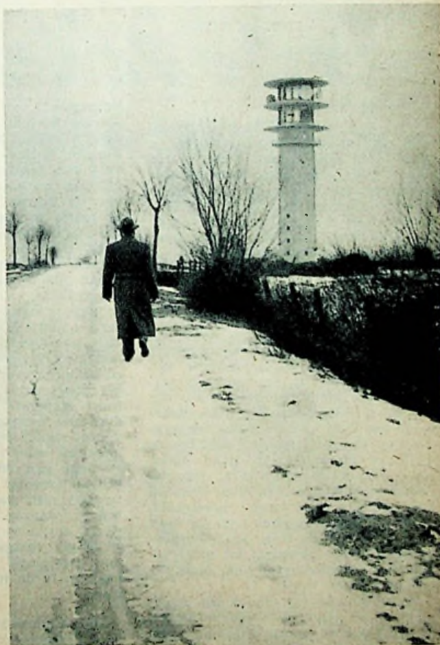
Rechts het driesprong-station te Mellendorf met zijn 50 m hoge toren. De straler links wijst in de richting Hamburg, de beide andere wijzen naar Keulen en Hannover.
